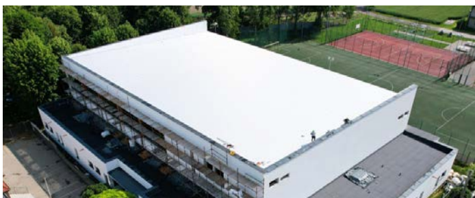
Budowa hali sportowej z częścią socjalno-bytową i infrastrukturą towarzyszącą w Dobieżyńcu. Zadanie rozpoczęte w 2023 roku. Dofinansowanie z Rządowego Funduszu Polski Ład: Program Inwestycji Strategicznych w kwocie 5 mln zł, z Ministerstwa Sportu i Turystyki: Programu Wsparcia Inwestycji Sportowych w kwocie 2,5 mln zł. Pozostałe środki: z budżetu gminy. Planowany koszt inwestycji: 10,5 mln zł.
