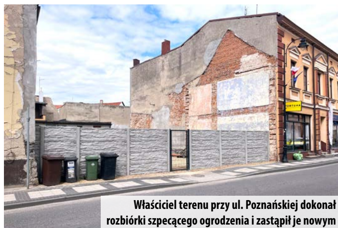
Teren przy ul. Poznańskiej po dokonanej rozbiórce budynku, długo pozostawał nieuporządkowany
