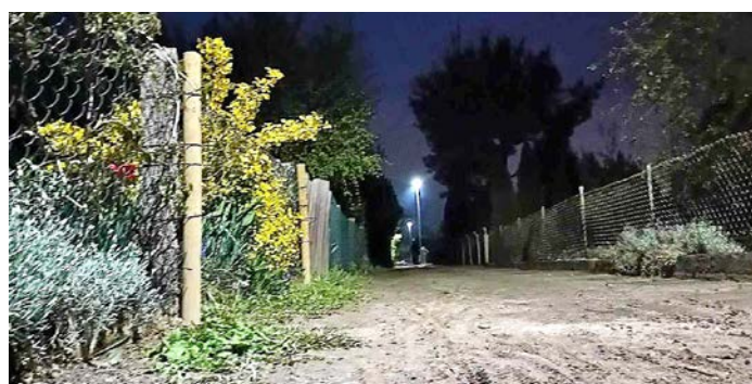
Budowa oświetlenia przy Rodzinnych Ogródkach Działkowych im. Kosynierów Bukowskich – 16 lamp, ROD Przy Torach – 8 lamp, ROD im. 700-lecia Buku – 16 lamp. Zadanie realizowane w ramach modernizacji oświetlenia drogowego i ulicznego stanowiącego majątek Enea. Koszt zadania: na poziomie 300.000 zł.
