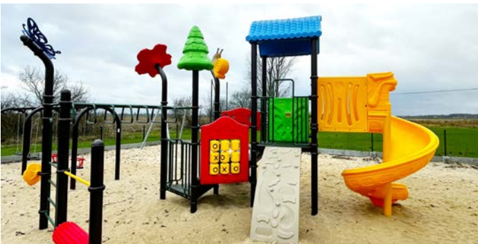
Budowa nowego placu zabaw w sołectwie Wielka Wieś – ul. Folwarczna. Dofinansowanie z samorządu województwa wielkopolskiego: Program Rozwoju Obszarów Wiejskich poprzez Lokalną Grupę Działania „Źródło” w kwocie 123.951 zł. Koszt zadania: 194.800 zł.
