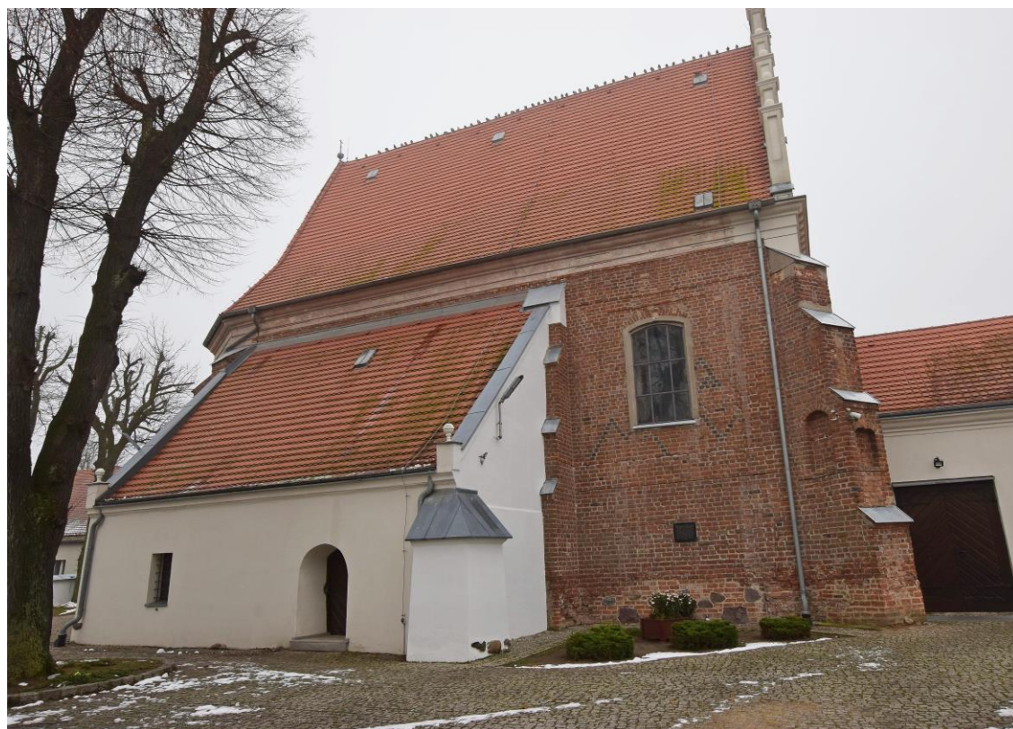
Fot.2. Elewacja północna kościoła
