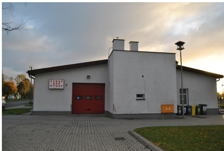
Remiza i świetlica wiejska w Otuszu
