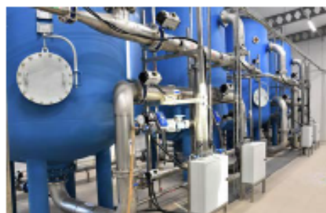
Stacja Uzdatniania Wody w Kalwach gotowa
