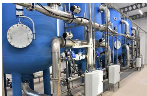
Stacja Uzdatniania Wody w Kalwach gotowa
