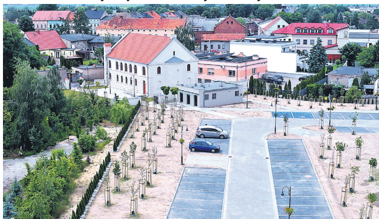
Parking buforowy przy ul. Wielkowiejskiej w Buku
