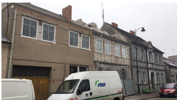
Zdjęcie 19. Odbudowa kamienicy przy pl. S. Reszki.
