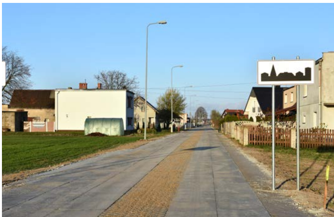
Przebudowa drogi w m. Michalin (obręb Dobieżyn)
