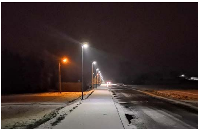
Budowa oświetlenia ulicznego na ścieżce rowerowo-pieszej Buk-Szewce
