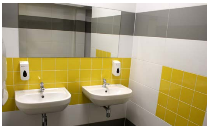
Remont pomieszczeń stanowiących zaplecze sanitarne szatni w budynku hali sportowej OSiR w Buku
