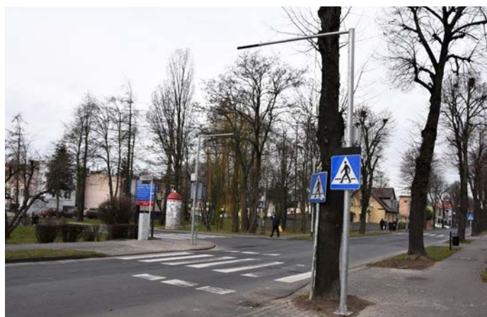
Modernizacja przejścia dla pieszych
