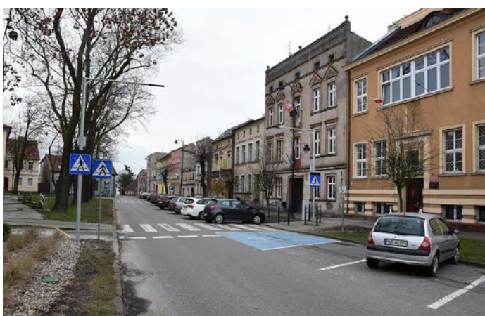
Modernizacja przejścia dla pieszych
