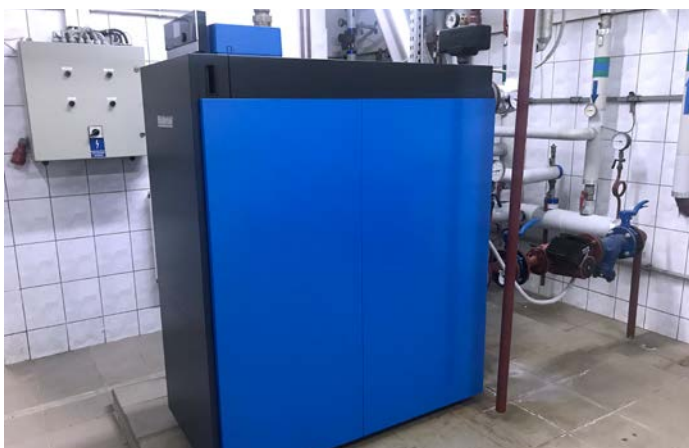
Biblioteka i Kino „Wielkopolanin” – remont instalacji gazowej z wymianą pieca
