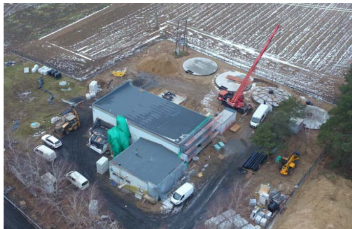
Przebudowa Stacji Uzdatniania Wody w Kalwach
