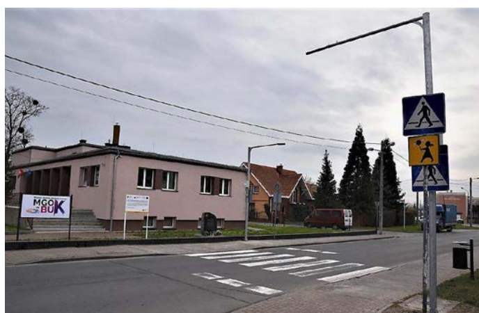
Modernizacja przejścia dla pieszych – ul. Dworcowa
