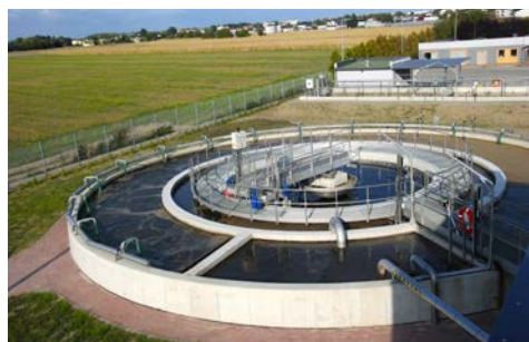
Nowa oczyszczalnia ścieków str. 12
